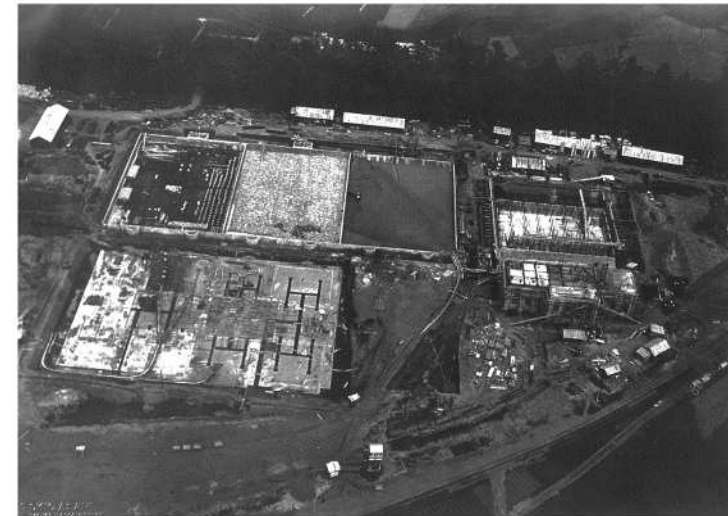
昭和10年 工事中の寒川浄水場
