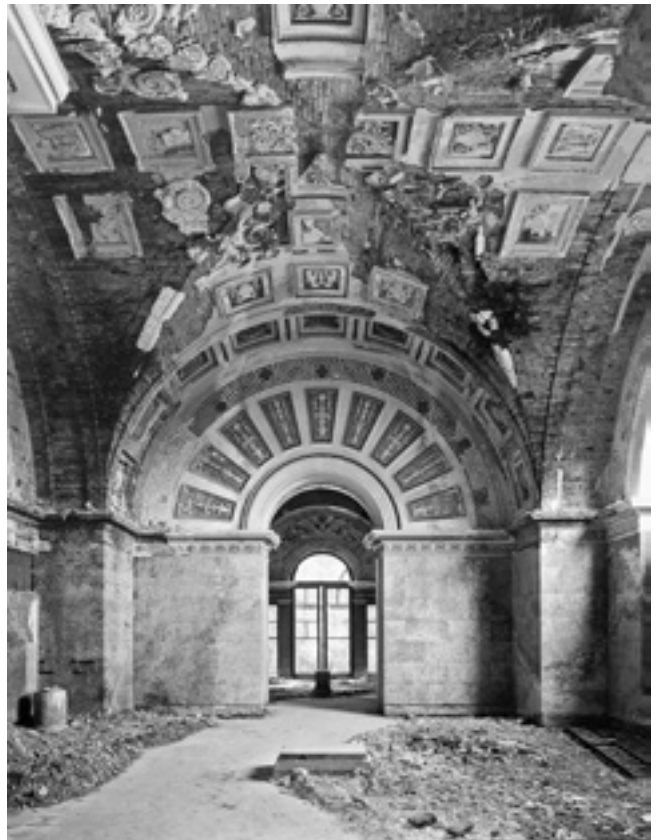
Glyptothek, stark beschädigter Westflügel (Foto: Foto Marburg, 1946)
