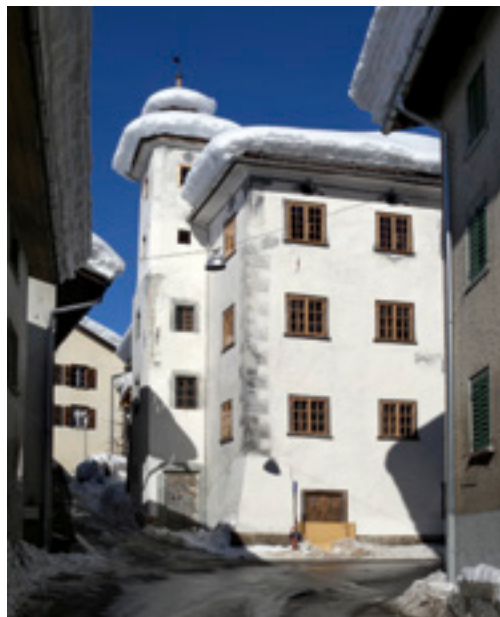
Türralihuus vor und nach der Außenrenovation (Foto: Valendas Impuls)
