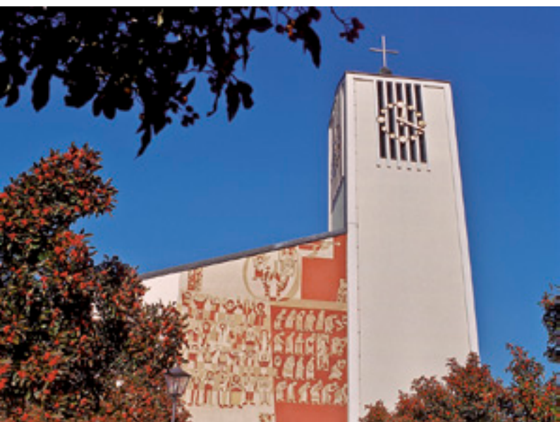
Poppenricht. Die Südseite der Kirche mit dem großflächigen Sgraffito vom Jüngsten Gericht über dem Eingang (Foto: Georg Pickl)
