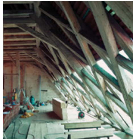
Dachwerk, Windverband (Foto: Nele Reichel, Büro Obel und Partner)
