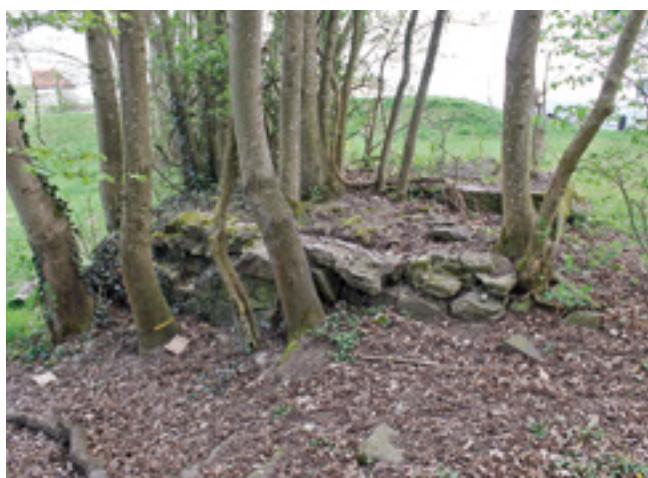
Passau, Thingstätte, 1934/35. Baustrukturen im östlichen Bühnenbereich, Bruchsteinmauerwerk und betonierter Schacht (Fotos: BLfD, Christian Later, 2014)
