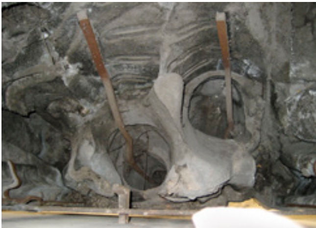
Abb. 5. Endoskopie mit einer flachen Digitalkamera durch einen Spalt zwischen Figur und Gebäudewand im Figureninnenraum. Dokumentation von Aufhängung und Innenraum einer Zinkguss-Fassadenfigur am Münchner Völkerkundemuseum. Die Aufnahme liefert eine Fülle von Informationen über die Wandbefestigung und statische Sicherung der Figur. Selbstauslöser, Autofokus, Automatikblitz
