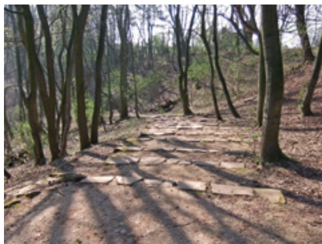
Braunschweig, Thingstätte am Nußberg, 1934/35. Ehem. Treppenabgang zu den Rängen
