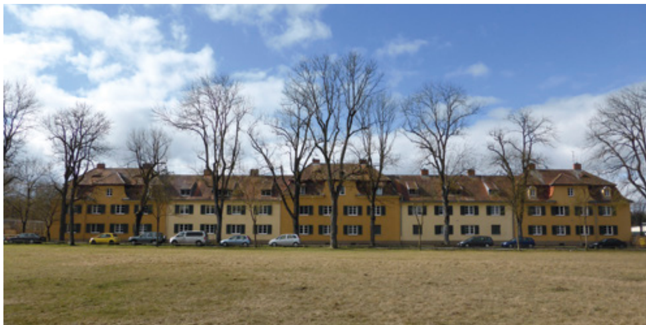
Augsburg, Königliches Landgestüt. Blick von Osten auf die Wohngebäude (13) (Foto: BLfD, Doris Ebner)
