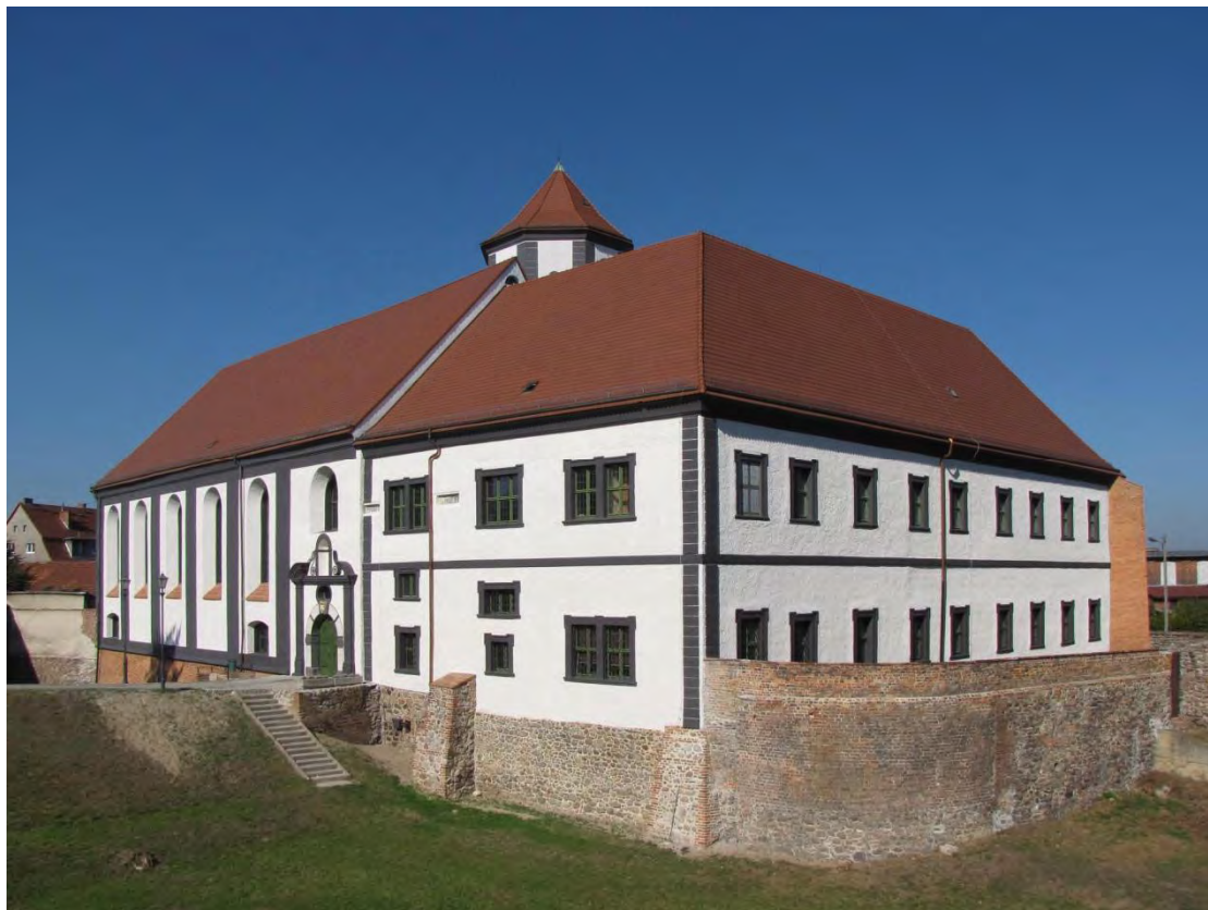
Ryc. 1. Książęcy zamek piastowski w Koźuchowie, widok na obiekt od strony SE. Stan po remoncie w latach 2015-2016. Fot. Z. Szukielowicz.
