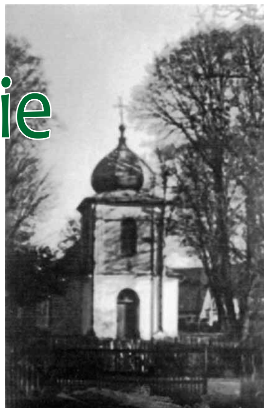
Murowana świątynia w Mrzygłodzie, widok na dwukondygnacyjną wieżę przykrytą baniastym hełmem, stan przed 1947 r.
