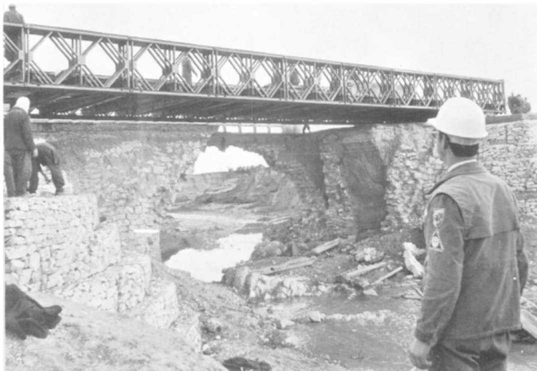
Tunesien-Einsatz 1969/70 des Technischen Hilfswerks. Nach der Überschwemmungskatastrophe in Tunesien setzte die Bundesregierung das THW zum Bau von 6 Straßenbrücken ein.
