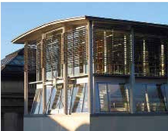
Рис. 17. «Штайб-Бау». Проект архитекторов Вилфрида и Катарины Штайб (1991–2002). Внешний фасад (фрагмент) [18]
