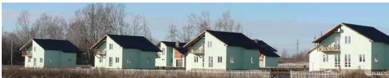
Рис. 2. Цепочка коттеджей в ООО «Строитель» Кромского района
