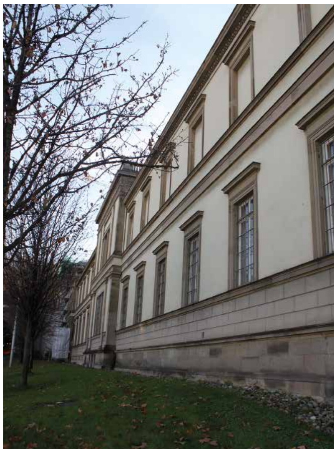
Рис. 1. Здание Государственной галереи в Штутгарте. Проект архитектора Готтлоба Георга фон Барта (1839–1843). Боковое крыло со стороны улицы Арнульф-Клетт-плац
