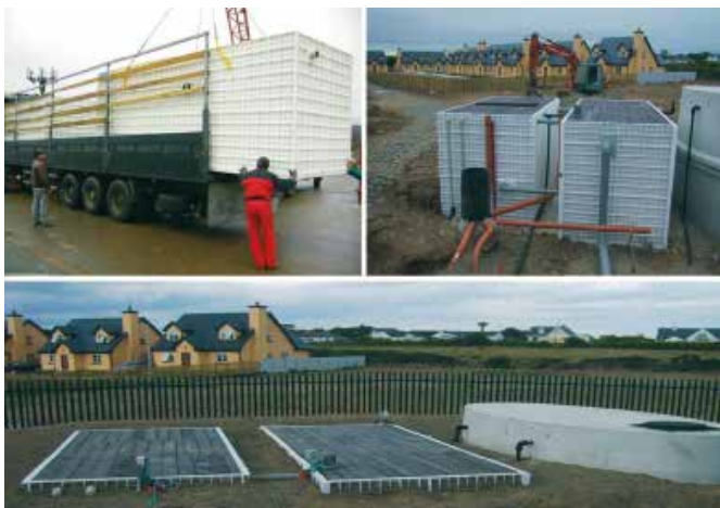
Рис. 5. Упакованная станция очистки (MINICLAR технологии USBF), предназначенная для средних объектов, у которых нет возможности присоединиться к канализации (коттеджные посёлки, жилые комплексы, группы блокированных домов, малые гостиницы, пансионаты; до 500 ЭЖ) [13]
