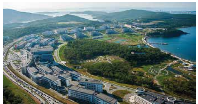
Рис. 4. Тихоокеанский научно-образовательный центр на острове Русский. Панорама застройки
