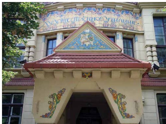
Рис. 5. Здание бывшего художественного училища в Харькове. Фрагмент общего вида и фрагмент фасада. Архитектор К.Н. Жуков. 1912–1913 годы
