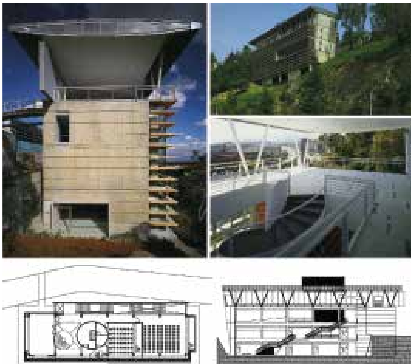
Рис. 8. Центр экономических исследований и обучения. Мехико Сити. Общие виды (кровля аэродинамических скульптурных очертаний, солнцезащитные экраны южного фасада, рекреационная терраса с видовыми площадками), план третьего этажа, разрез
