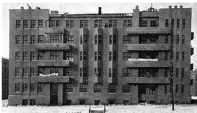
Рис. 14. Жилой дом «Табачник» на проспекте Правды, 1. Архитекторы А.З. Коган, П.И. Фролов. 1929–1931 годы
