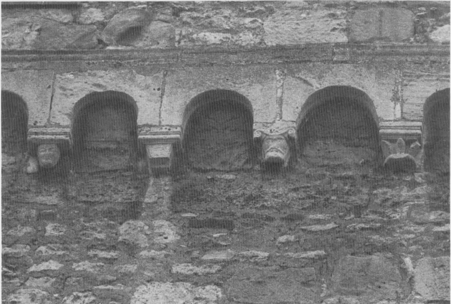
Abb. 11 Figurenkonsolen der äußeren unteren Nordwand des Querhauses
