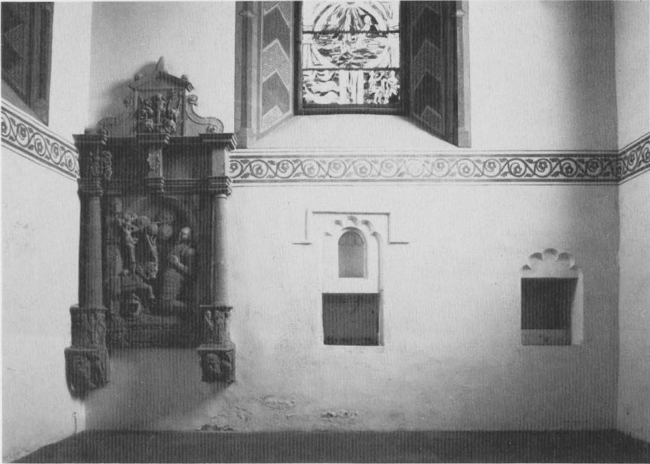
Abb. 17 Ansicht der Chorabschlußwand
