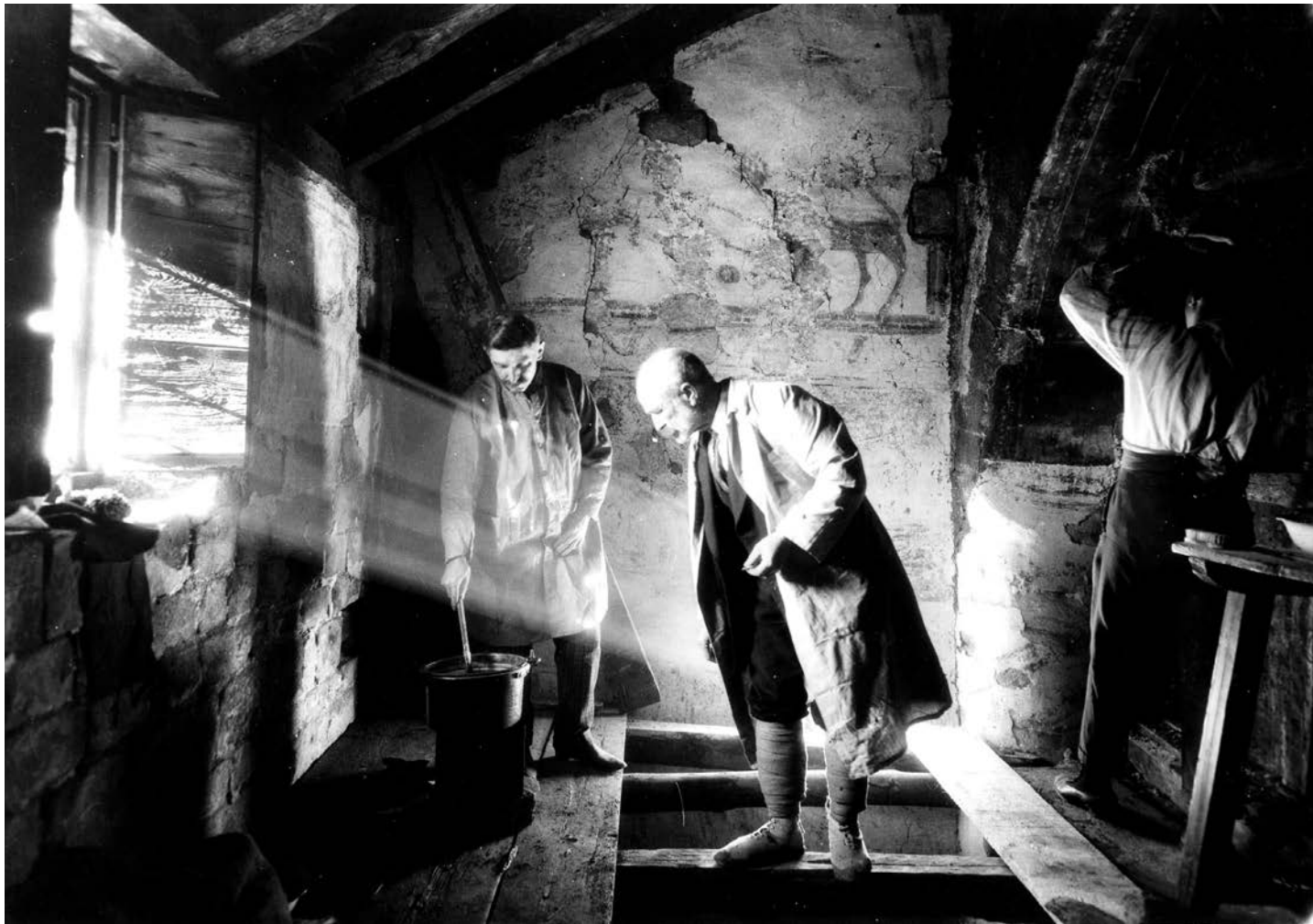
Santa Maria de Taüll, 1922: treballs per a l'arrencament de les pintures murals. Foto Arxiu Amatller d'Art Hispànic
