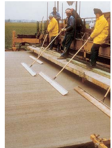
Autobahnbau, Besenstrich zur Texturherstellung
