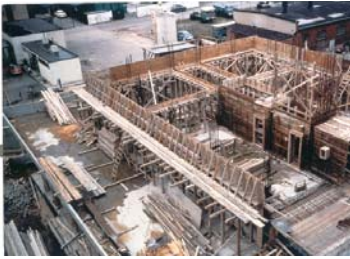
Erweiterungsbau 1965 im Bau
