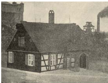
Bleibtrens Wohnhaus in Züllchow
