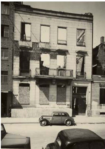
Ausgebranntes Verwaltungsgebäude in der Eckstraße 17, 1943
