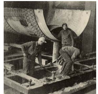
Reparatur des Lepolofens bei Teutonia, 1946
