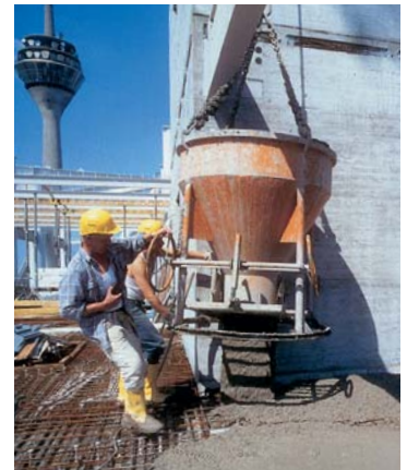
Verarbeiten von Frischbeton
