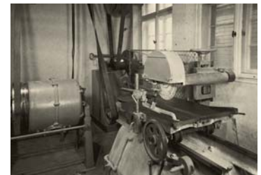
Kugelmühle und Steinschneidemaschine, Eckstraße 17
