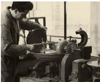
Mitarbeiter am Steinbrück-Schmelzer-Mörtelmischer, 1960er Jahre
