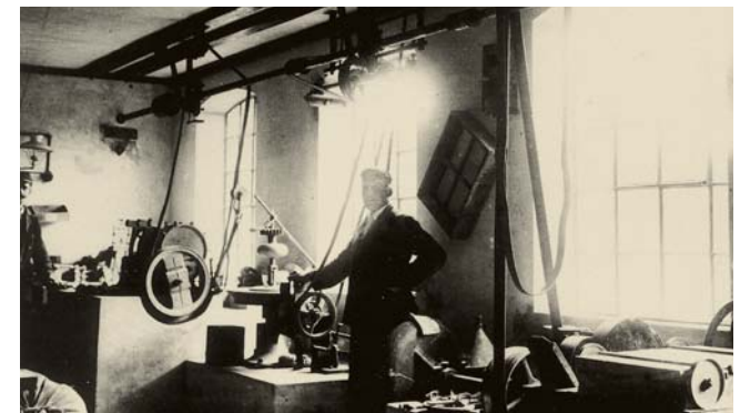
Die ersten Maschinen für die Zementprüfung: rechts Siebmaschine, Mitte Mischmaschine, links Hammerwerk, 1913
