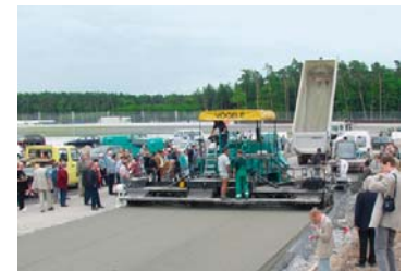
Dränbeton-Versuchsstrecke
