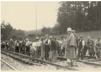
Tilly Behringer (im Vordergrund) besucht eine Arbeiterkolonne beim Gleisbau, ca. 1935
