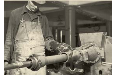
Herstellung von Betonrohren im Zementwerk Leube in Gartenau (Österreich), 1951
