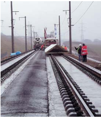
Bau einer ICE-Eisenbahnstrecke
