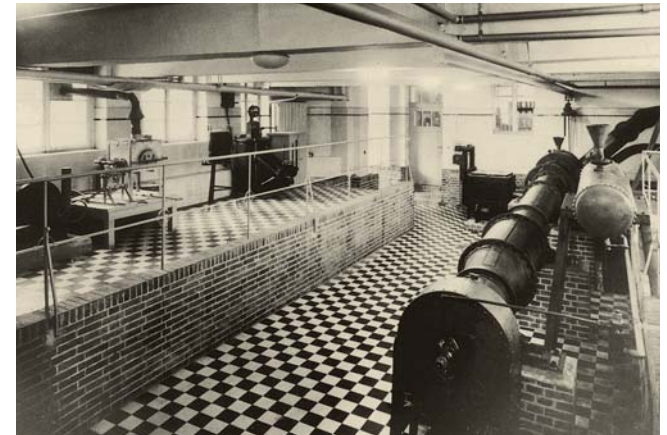
Ofen zur Klinkerherstellung 2. Generation, 1934, Roßstraße
