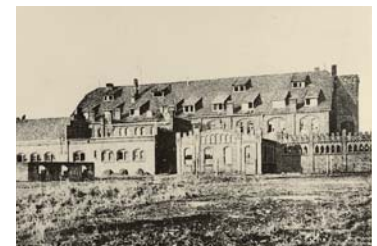
Ledigenwohnheim des Misburger Portland-Zementwerks „Teutonia“, ca. 1900
