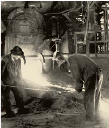
Hochofenabstich Niederrheinische Hütte, 1951
