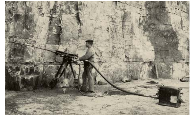
Steinbrucharbeiter mit langem Bohrer
