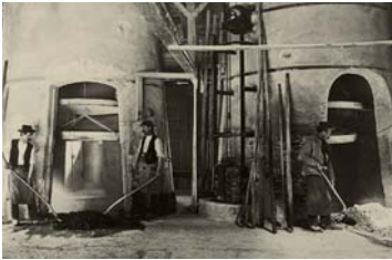
Befüllen von Schachtöfen bei Leube, Gartenau
