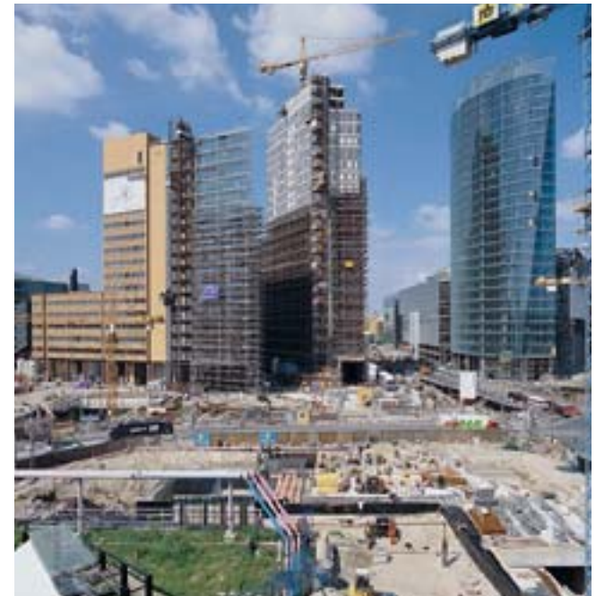
Betonbaustelle Potsdamer Platz in Berlin
