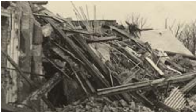
Zerstörtes Gebäude, Roßstraße
