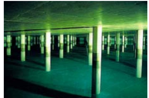
Trinkwasserbehälter aus Beton
