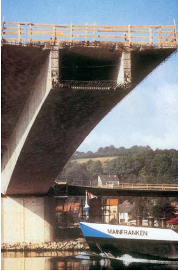
Neubau einer Eisenbahnbrücke über den Main
