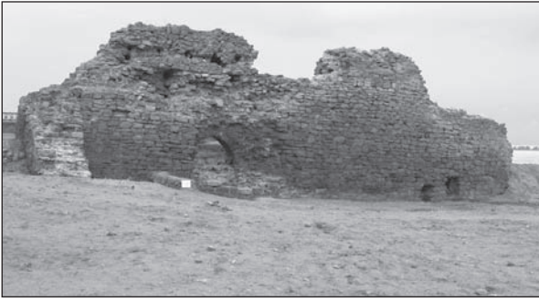
Рис. 4. Східна стіна барбакану до проведення консерваційних заходів (фото 2006 р.)
