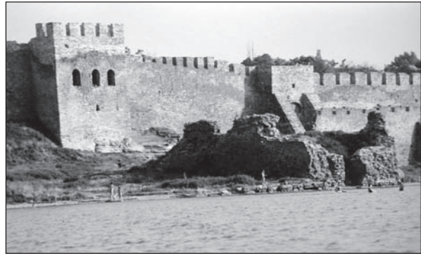
Рис. 6. Розташування північно-західної частини барбакану до обвалування
