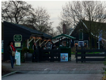
Schipperplein: loodsen en werkplaatsen.
