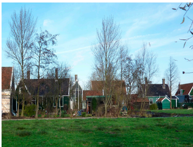
Padenstructuur: informele achterkanten.
