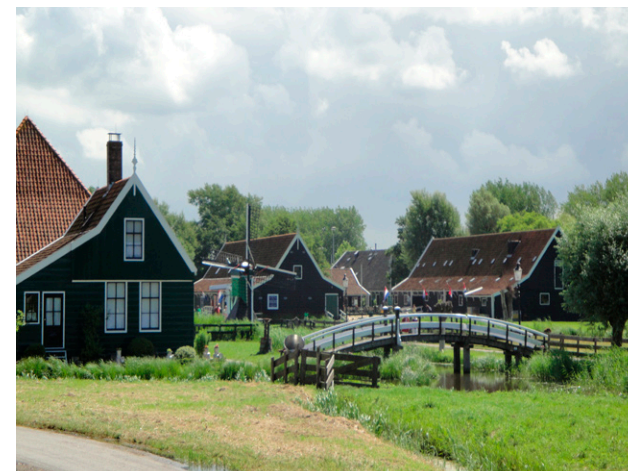
Schipperplein: concentratie van pakhuizen in een niet-historische setting.
