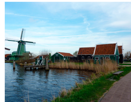
Toilettencomplex aan de Kalverringdijk en de Zaan.
