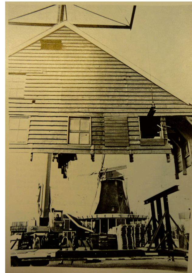
Verplaatsing van pakhuis Kraai, [Stichting Zaanse Schans, jaarverslag 1975]
