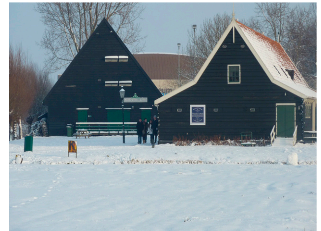
12. Grootchaligheid (pakhuisen, Zaans Museum, Verkadepaviljoen en St. Michaellyceum) versus de kleinschaligheid van het houtbouwreservaat.
