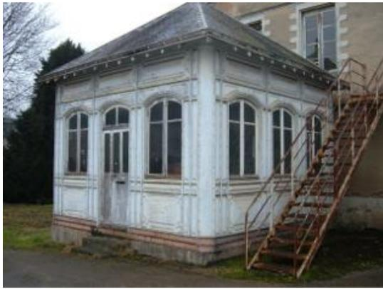
On ne sait actuellement rien de cette construction, indéniablement du système Danly. La photographie permet cependant de voir le support des murs, fait d'un double fer U (voir les brevets et la description du système). Les murs sont par ailleurs très compliqués, offrant une variété de panneaux qui semble exagérée, sans rapport avec la modestie dont pourrait se suffire l'édifice.
