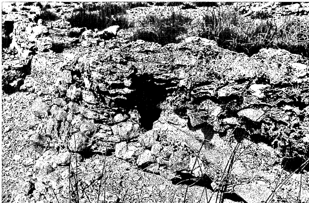
FIG. 12. — Hr Moussa ; partie de l'aqueduc.
