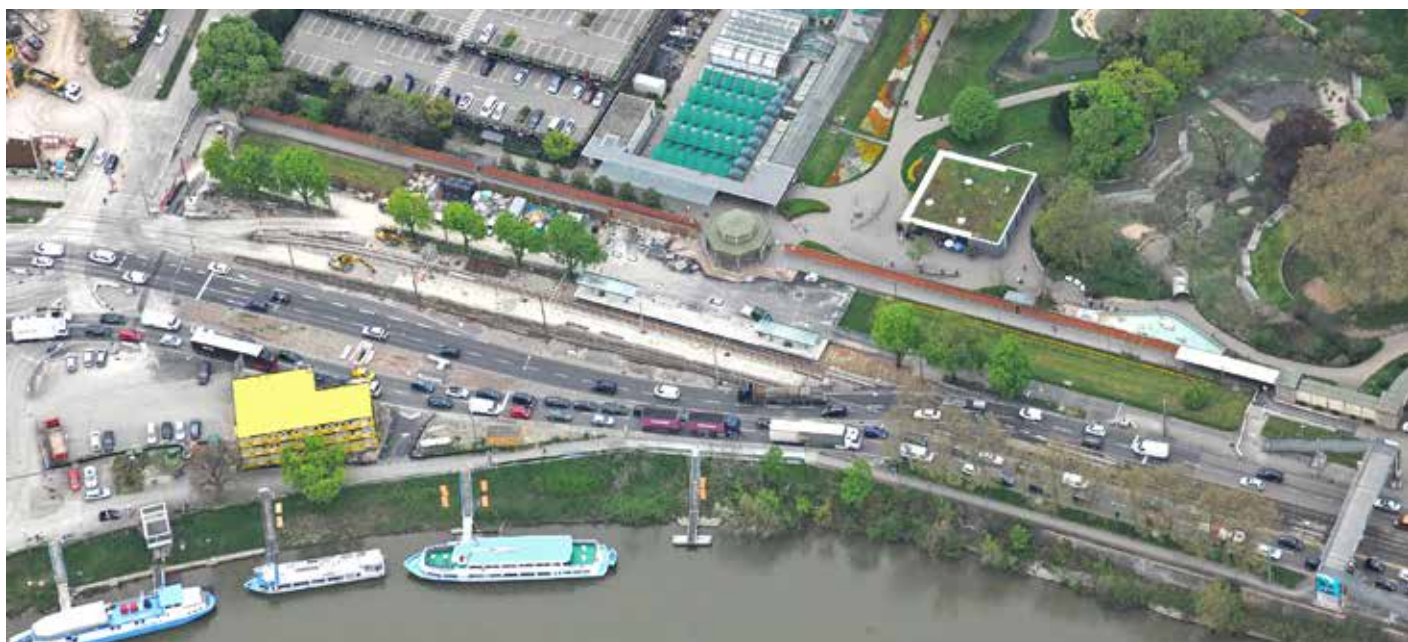
Verlegung der Haltestelle Wilhelma
