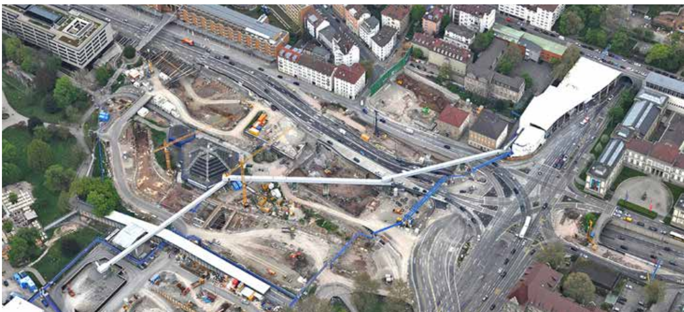
S21-Folgebmaßnahme, Baustelle an der Haltestelle Staatsgalerie
