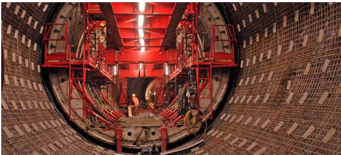
Blick in die Tunnelröhre der S21-Folgemassnahme Heilbronner Straße
