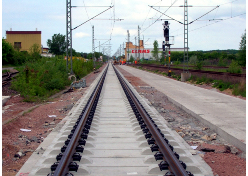
Feste Fahrbahn Bauart Bögl
