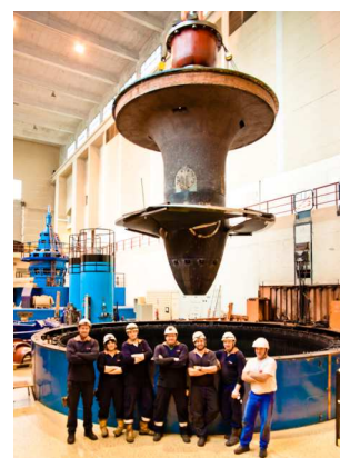
Rénovation du groupe de production de la centrale de Temple-sur-Lot. EDF © Médiathèque
