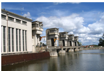
Barrage et centrale de Temple-sur-lot EDF © Didier Marc
