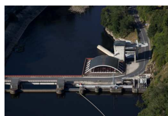
Barrage et centrale de Cambeyrac EDF © Maxime Authier
