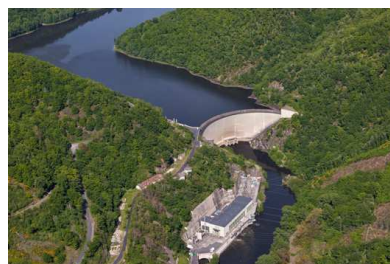
Barrage de Couesques EDF © Pierre Soissons
