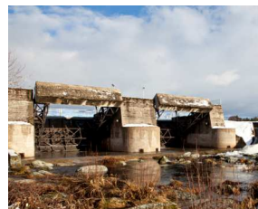
Digue de Ganivet EDF © Pierre Soissons
