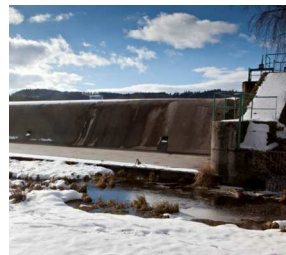
Digue du Moulinet EDF © Pierre Soissons
