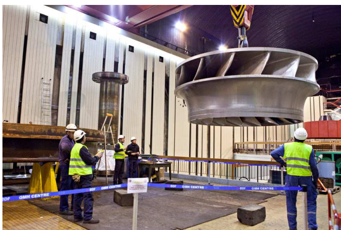
Démontage d'un groupe de production de la centrale hydraulique de Brommat par l'Equipe d'interventions mécaniques EDF de Mur-de-Barrez.
