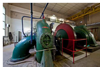
Barrage de Mels EDF © Pierre Soissons
