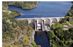
Barrage de Grandval EDF © Pierre Soissons
