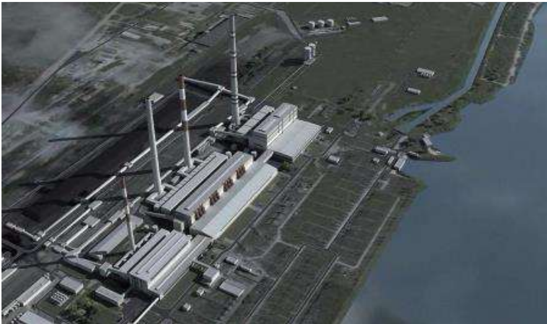
Блок №10 Троицкой ГРЭС
