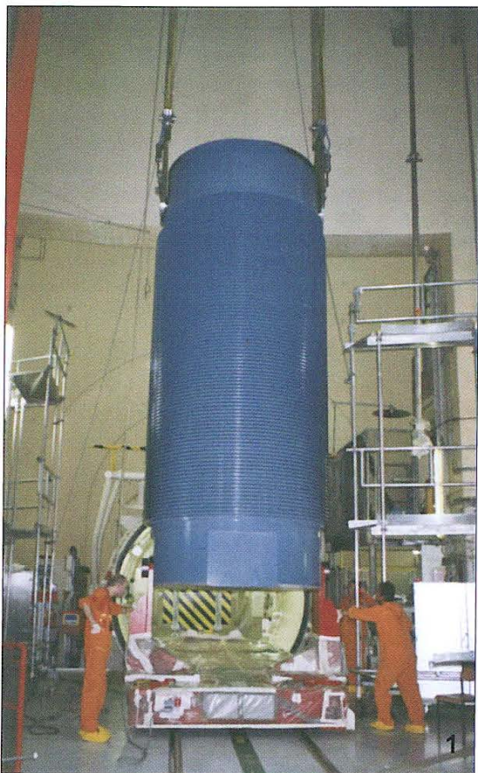
Bild 11: Einsatz des CASTOR® im Kernkraftwerk: Einschleusen (1), Vorbereitung zur Beladung (2), Beladung mit Brennelementen (3)
