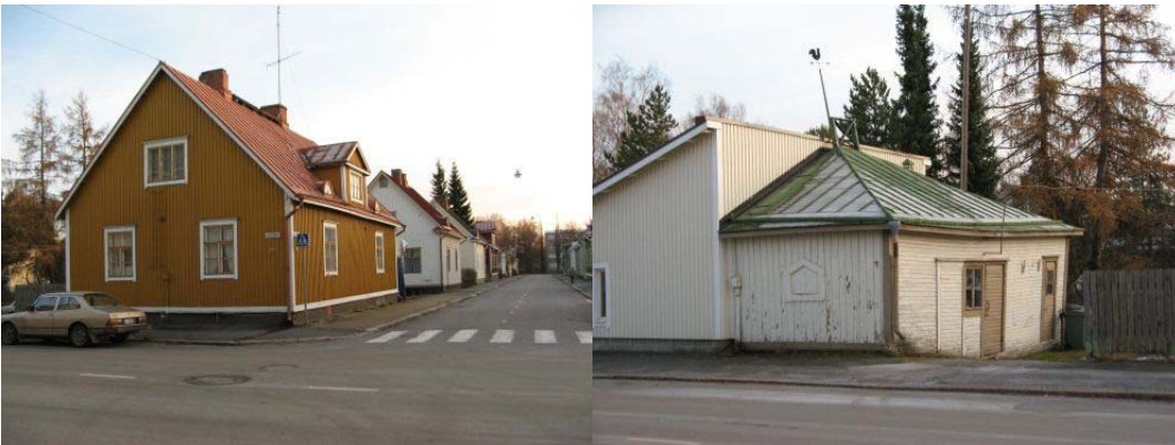
En välbevarad hörnbyggnad och dess uthus. Mellangatan 1. Foto: S. Öst.
