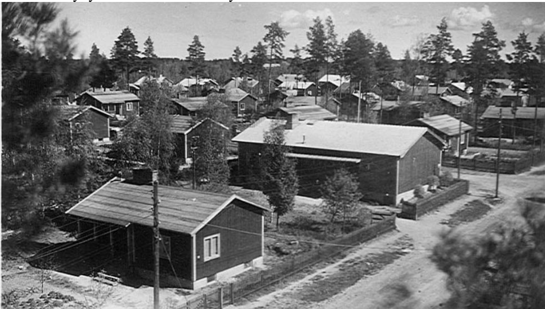
Kuva: I Serenius. PMA, Malmönkatu 25 ja Karjalankatu 22. Kulmarakennuksessa sijaitsi ennen kauppa. Samat rakennukset näkyvät myös yllä.
