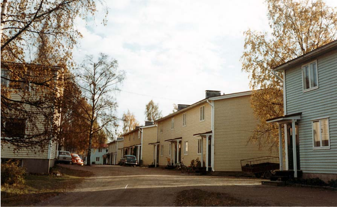
Fotografi från år 1978 vid Ansasgatan 2, medan Selvaaghusen fortfarande har sin ursprungliga, norska fjällpanel. Två år senare bekläddes fasaderna med karatskivor. Fotograf: Mirjam Lehtikanto, 12.10 1978, Österbottens museums bildarkiv.
