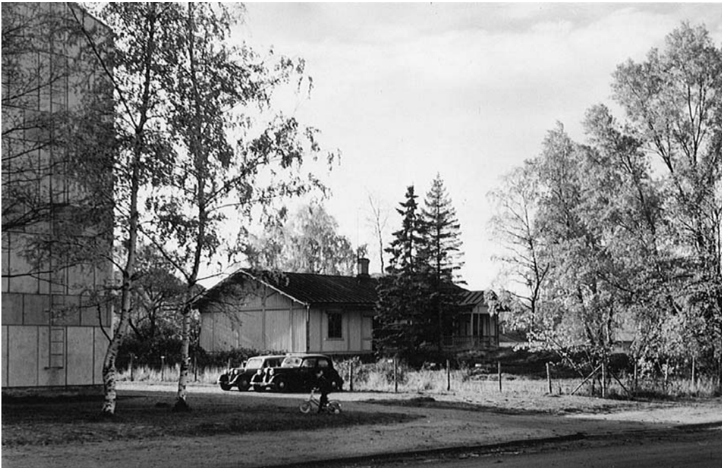
Stadsträdgårdens bostadshus sedd från Sandviksgatan. T.v. skimtar gaveln av det så kallade "kilometerhuset", ritat av Viljo Rewell. Foto: Österbottens Museums bildarkiv, Vasa Centralarkivs foton, M.E. Palomäki, 15.10 1959.
