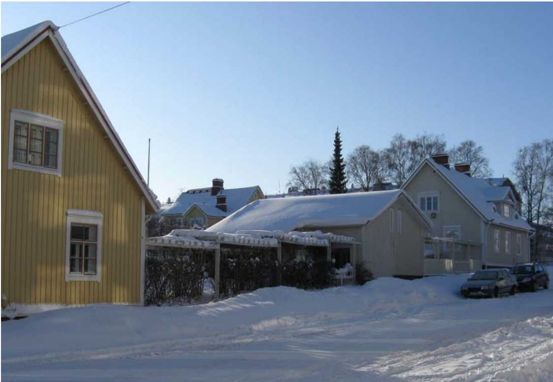
Nuvarande staket mellan husen vid Sandviksgatan 28–30. Foto: Pia Hartvik, 12.2.2010.
