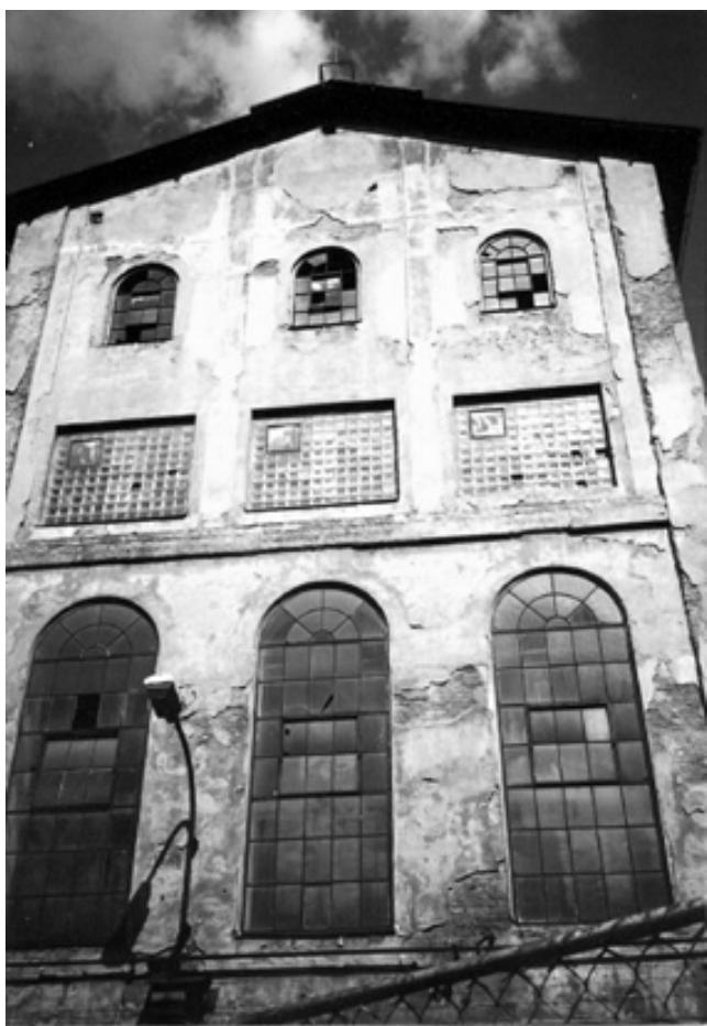
Průčelí budovy rafinerie. Foto Tomáš Šenberger, 2002
