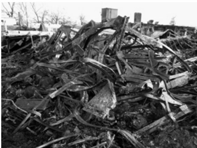
Zbytky roztavených konstrukcí budovy po požáru. Foto Martin Ebel, říjen 2008
