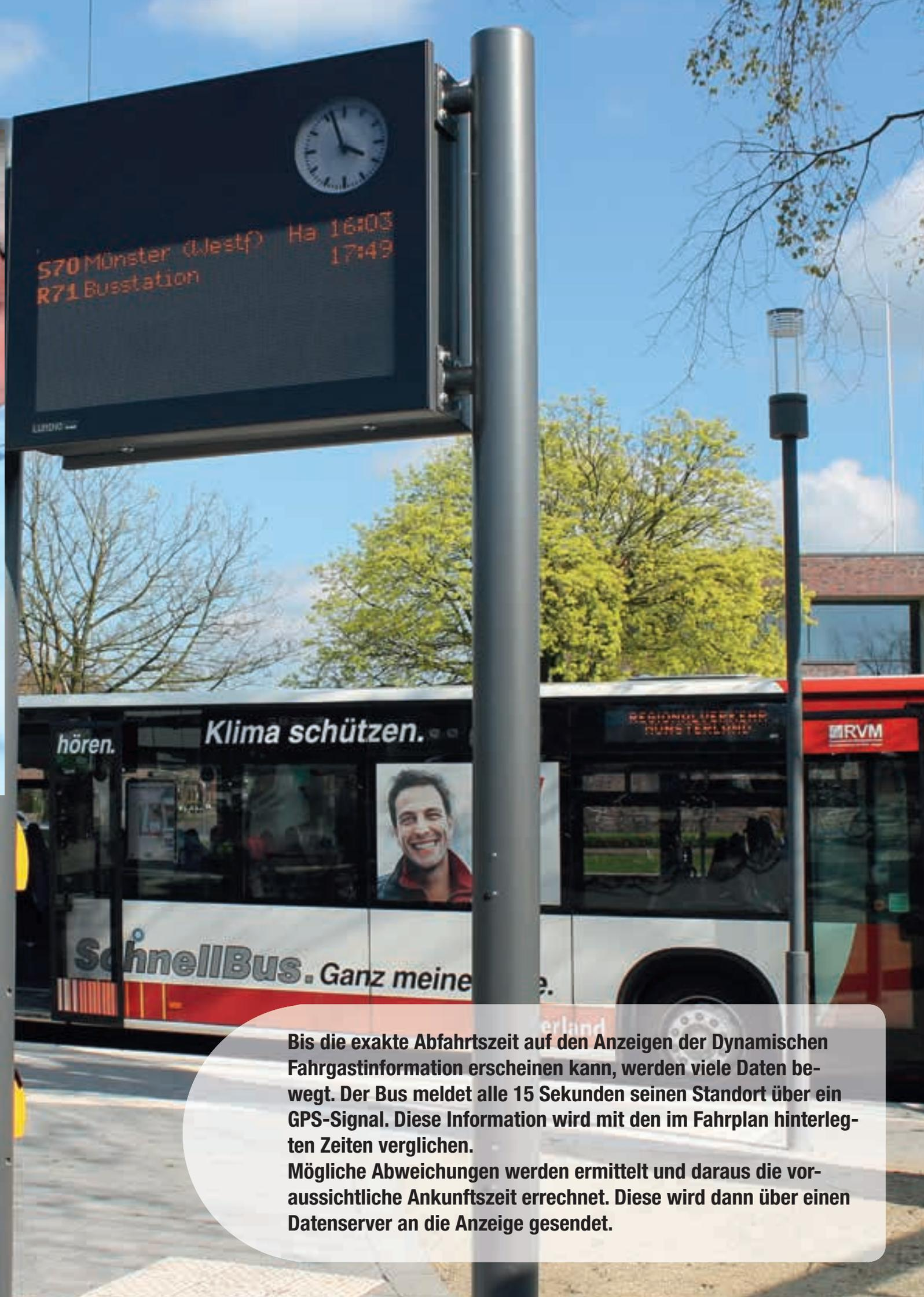
**Bis die exakte Abfahrtszeit auf den Anzeigen der Dynamischen Fahrgastinformation erscheinen kann, werden viele Daten bewegt. Der Bus meldet alle 15 Sekunden seinen Standort über ein GPS-Signal. Diese Information wird mit den im Fahrplan hinterlegten Zeiten verglichen. Mögliche Abweichungen werden ermittelt und daraus die voraussichtliche Ankunftszeit errechnet. Diese wird dann über einen Datenserver an die Anzeige gesendet.**
