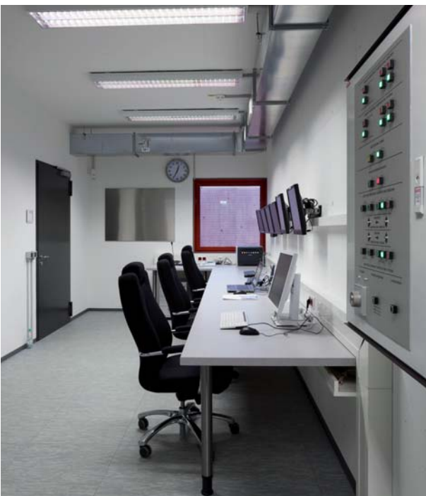
Betriebsgebäude mit Leitwarte
