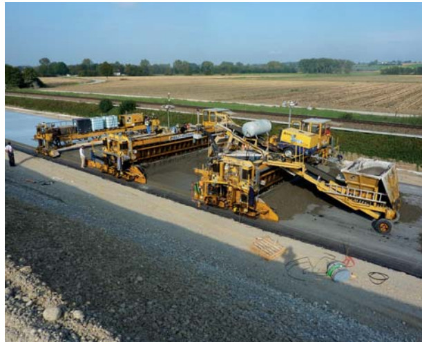
Einbau des Fahrbahnbetons
