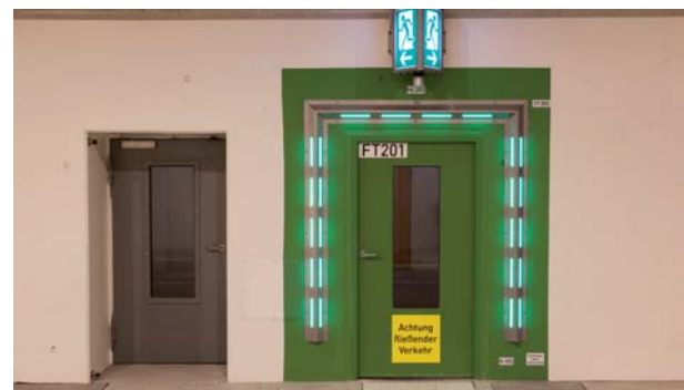
Notrufrnische und Fluchtwegtüren
