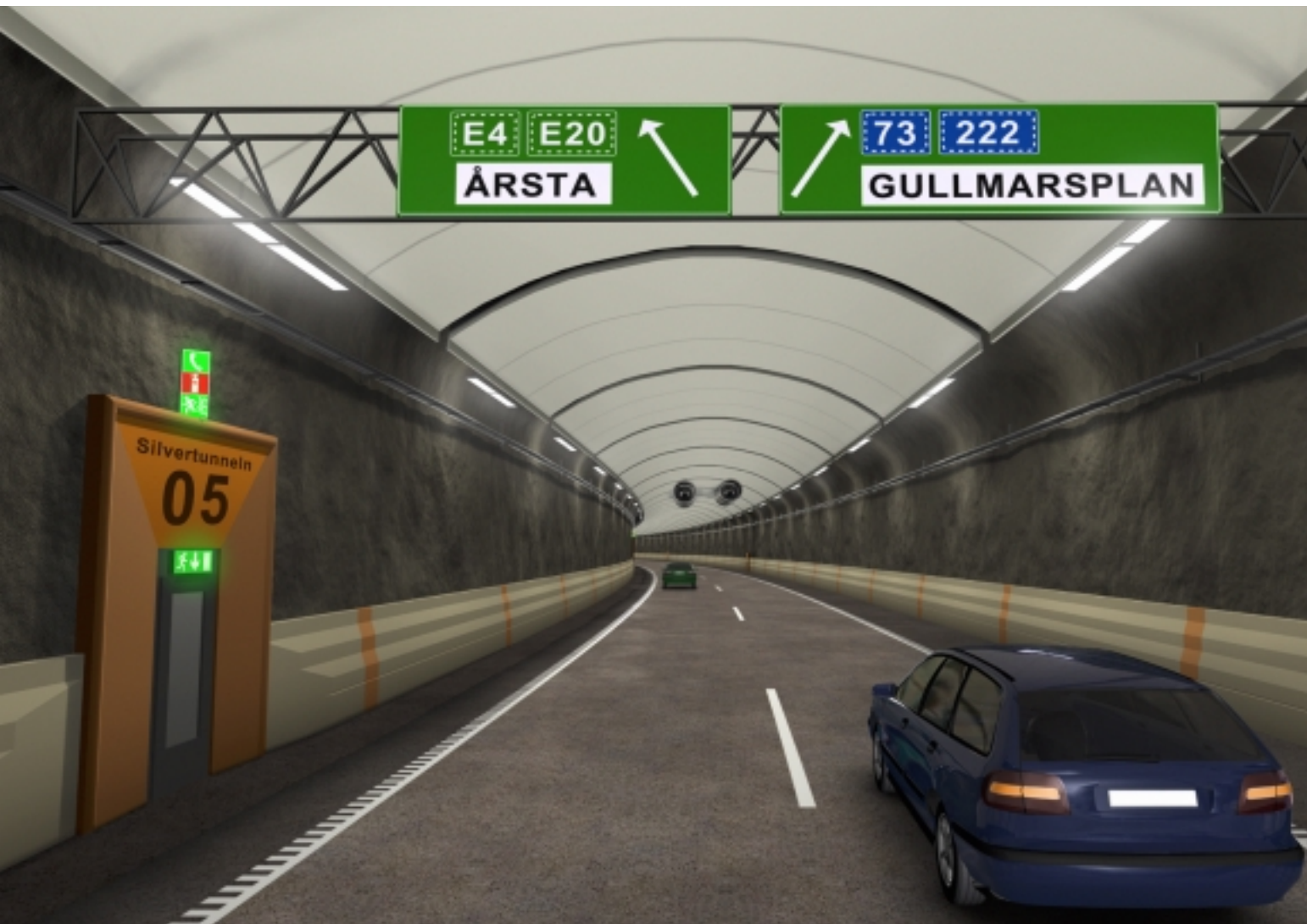
Södra Länkens stora kurvradier underlättar för trafikanterna att se vart vägen bär.
