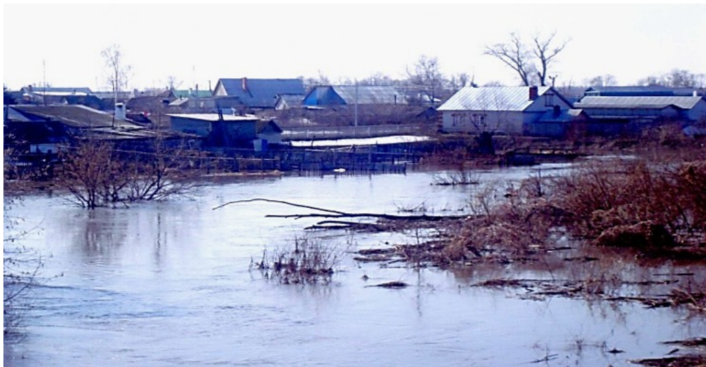
Участок реки Карла в период весеннего половодья до проведения работ по расчистке русла
