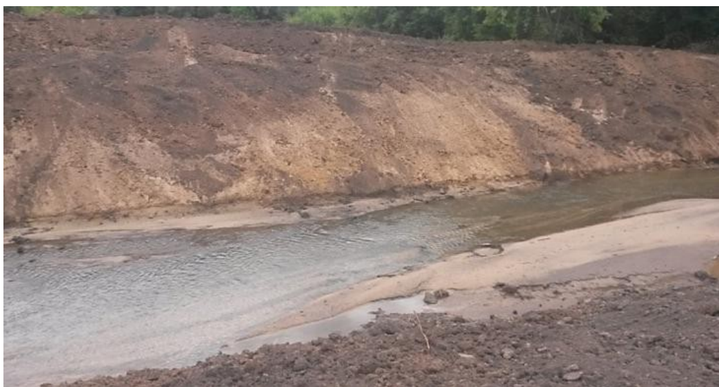
Участок реки Карла после окончания работ по расчистке русла в 2014 г.
