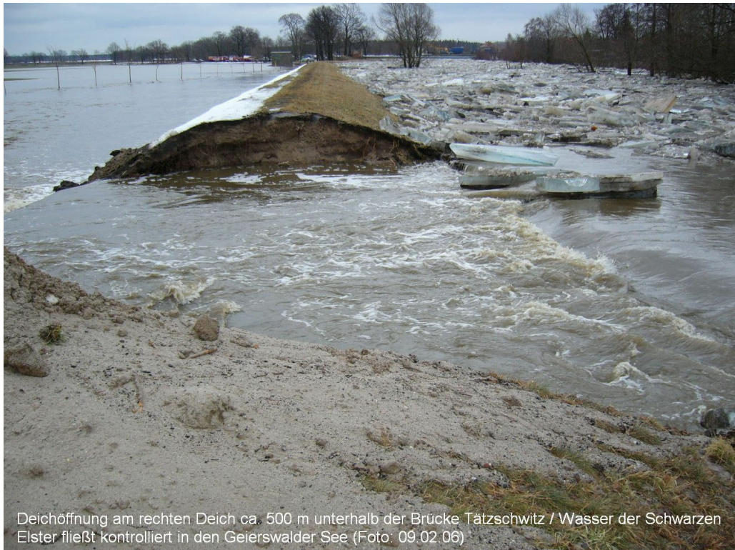
Abb. 5: Deichöffnung am Deich der Schwarzen Elster ca. 350 m unterhalb der Brücke Tätzschwitz (Foto: SMUL, 2006).
