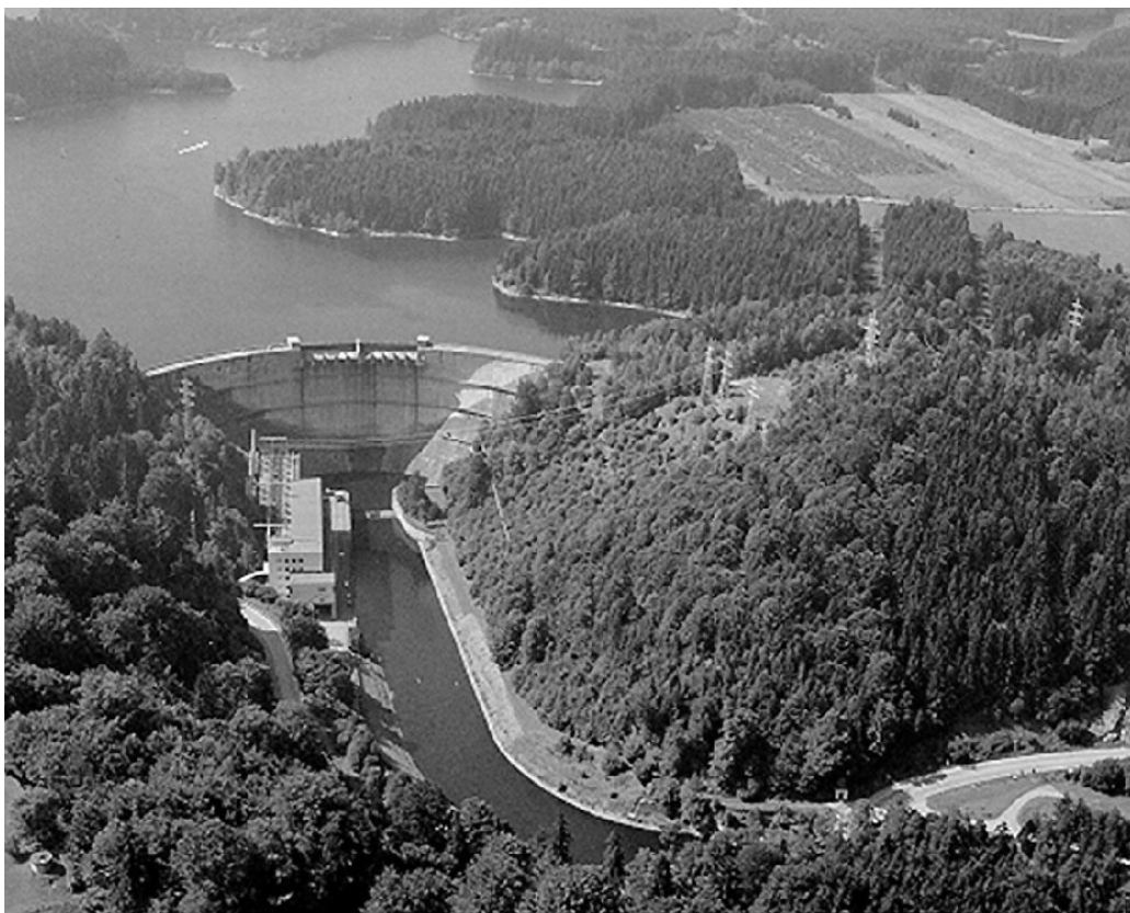
Abb. 1: Kraftwerk Ottenstein (Foto: EVN).
