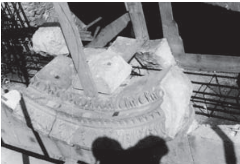
Particolare del rimontaggio di uno dei rosoni.
