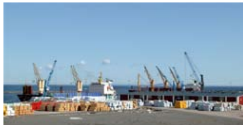
Virkeshantering Norra Kajen
