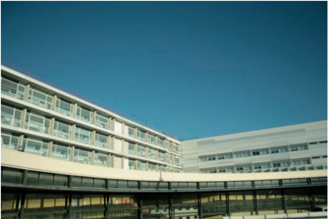
Nuevo edificio de la Facultad de Bellas Artes de San Carlos. Valencia
