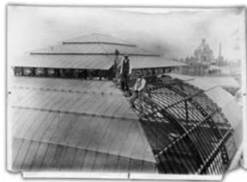
Fig. 2.- Autor Desconocido; Construcción de la Cúpula, ca. 1913, Colección de la Escuela Nacional de Artes Plásticas, México Distrito Federal.
