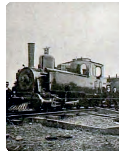
Primera máquina armada del ferrocarril de Chillán a las Termas
