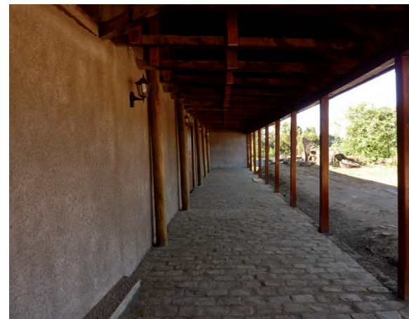
Exteriores bodega de vinos de Labraña, actual Fundo San Fernando. Restaurada después del terremoto de 27 de Febrero de 2010. Fundo San Fernando. 2014.
