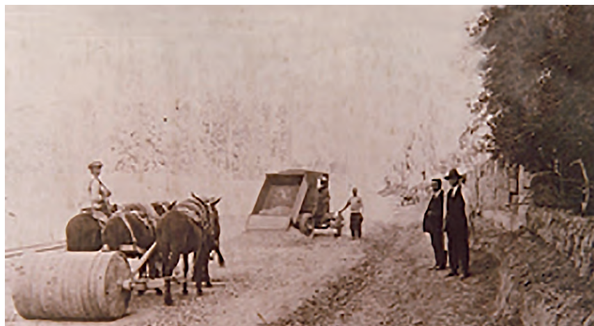
Trabajos de apisonado de caminos.(Min. Obras Públicas.)
