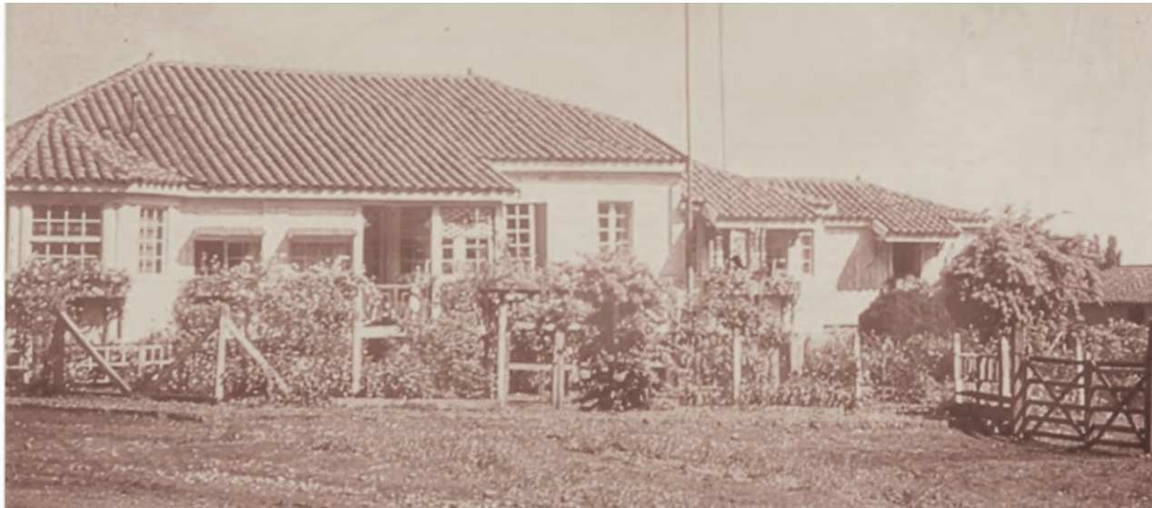
Fotos de la casa patronal del Fundo Pemuco de la familia Mutis Stevens. Esta casa estaba destinada a la habitación del Inspector de Alcoholes del Servicio de Impuestos Internos que certificaba y lacraba los envases de vinos y alcoholes producidos en las bodegas de la Hacienda Palpal. Posteriormente a la división y partición de las tierras por los herederos de don Luis Fernando Stevens, sus descendientes, la familia Mutis Stevens, remodelaron la construcción convirtiéndola en casa patronal. (Archivo familia Estrada Mutis.)
