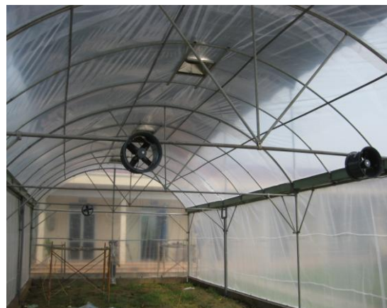
Hình 1. Thi công lắp đặt khung nhà lưới
