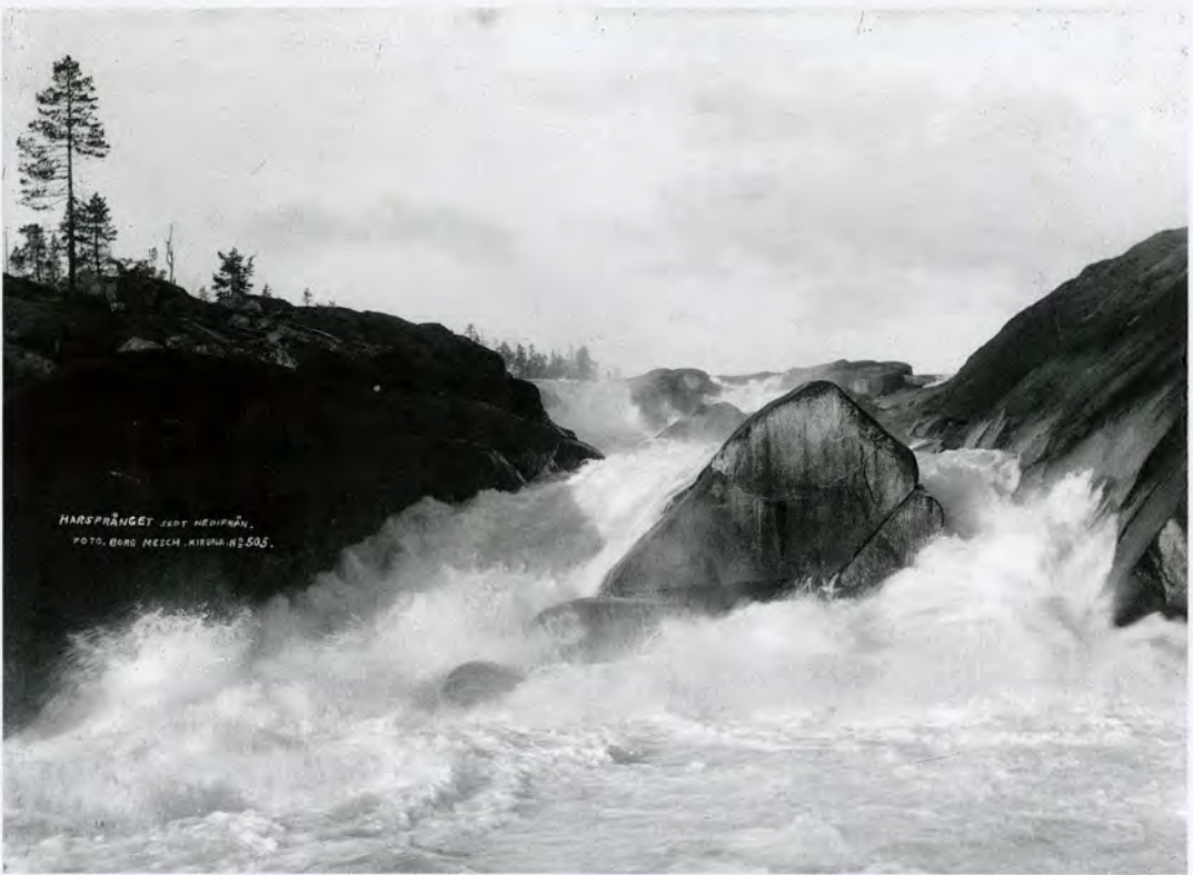
Bild 29. Harsprånget. Den smala förträngningen vid Harsprånget på ett fotografi från tiden före utbyggandet – inte bredare än att en hare kunde hoppa över? Foto: Borg Mesch. Kiruna kommuns bildarkiv.
