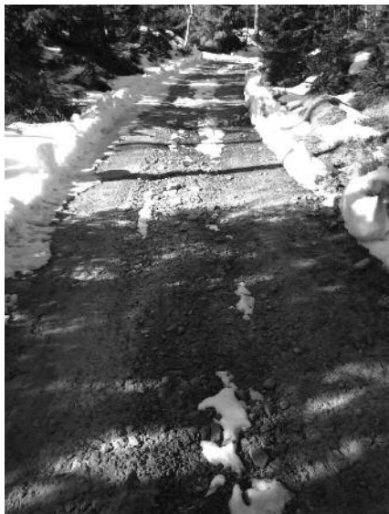
FIGUR 4. Del av den gamla landsvägen efter att en starkströmskabel plöjts ned i vägbanan. Foto: Claes B Pettersson, JLM.
