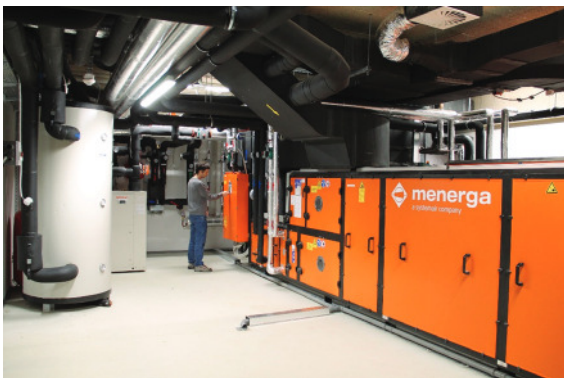
Slika 12: Sodobni prezračevalni sistemi v skladu z zahtevami in standardi za doseganje energetske učinkovitosti ter čistosti zraka v kemijskih laboratorijih
