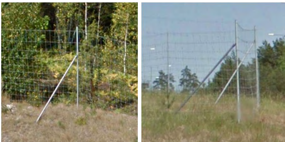
Figur 17. Exempel på behov av markområde för att staga upp och underhålla viltstängsel/fallskydd.
