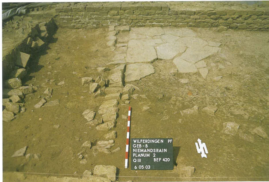
Abb. 112 Remchingen-Wilferdingen. Fußbodenbelag aus Sandsteinplatten in situ im Ostteil des Wirtschaftsgebäudes.
