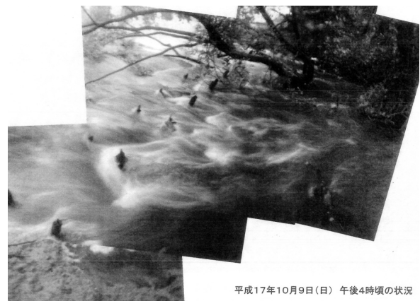
写真コラム 15-1 中堤の陥没により小合溜から大場川に流出する水（須見徹太郎撮影）
