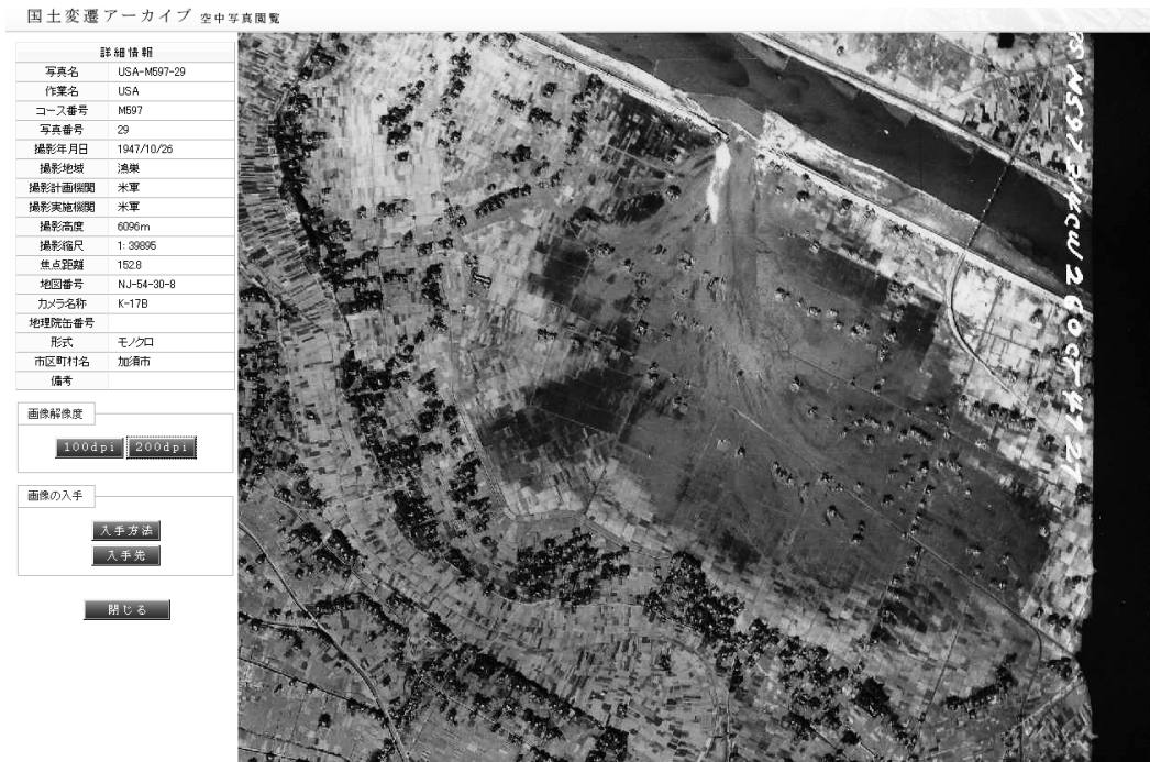
写真5-2 旧東村（現大利根町）の利根川決壊点（1947（昭和22）年10月米軍撮影）
