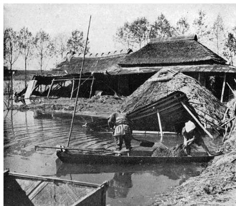
写真5-8 破壊された民家 （大利根町）（埼玉県, 1950, 「附録写真帳」）
