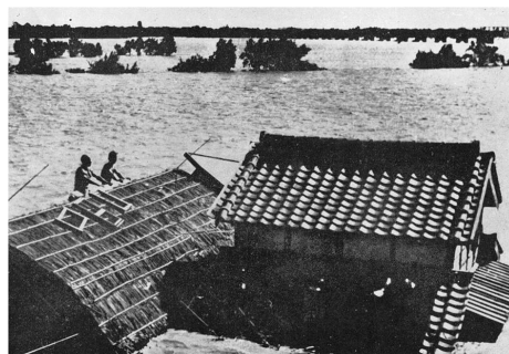
写真5-7 屋根上に避難（栗橋町） （埼玉県, 1950, 「附録写真帳」）
