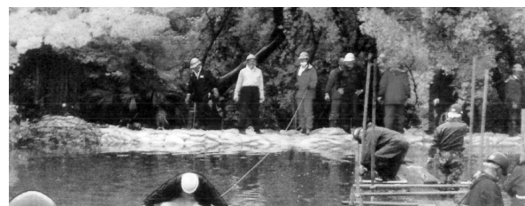
写真コラム 15-2 応急復旧工事の状況（須見徹太郎撮影）
