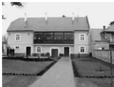
SLIKA 12. Dalj – Milankovićeva obnovljena kuća
