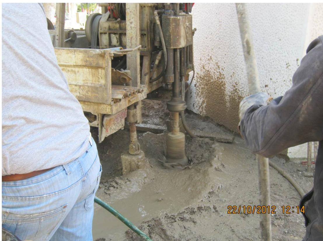
**3. Сечење на колови и лиење на бетонска плоча на длабочина од 2.40 м.**
