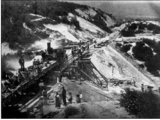
7. ábra A Piski-Petrozsény szárnyvonal pályája építés közben
