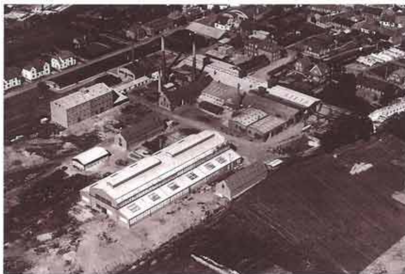
Varde Stålværks bygninger, maj 1949.
