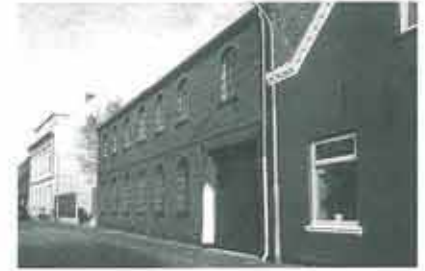
Værkstedbygning i Spigerborgade. (Smedegade 35).
