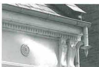
Nedløbsrør med "drueknæ".
