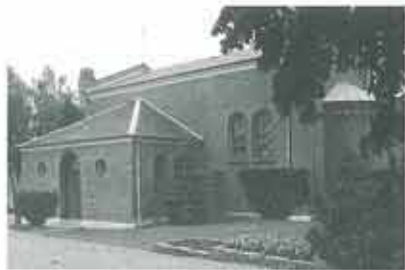
Kapellet, Lundvej 6, opført 1881.
