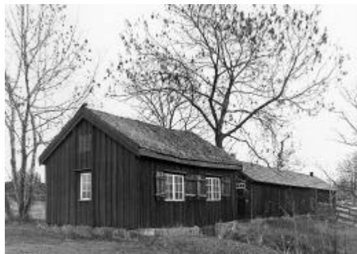
Sexstyverskrogen vid Himmelstalund, före renoveringen i mitten av 1990-talet, då torvtaket ersattes med brädor. Foto, Stadsarkitektkontoret, Norrköping.
