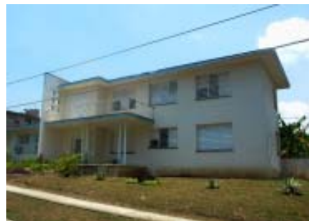
Vivienda en Calle 12 No. 5 del reparto Vista Alegre.
