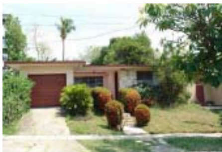
Vivienda en M, No.357 en Ampliación de Terrazas.
