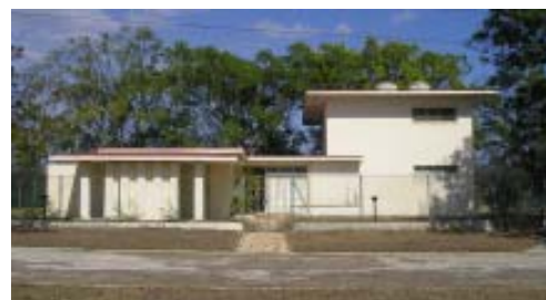
Pureza de líneas de los volúmenes construidos y los techos planos. Residencia en la calle del Mirador, Merrimac.
