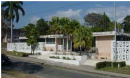
Vista de la antigua Sede del Consulado de Estados Unidos en Ampliación de Terrazas.
