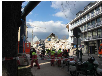
Situation nach dem Einsturz
