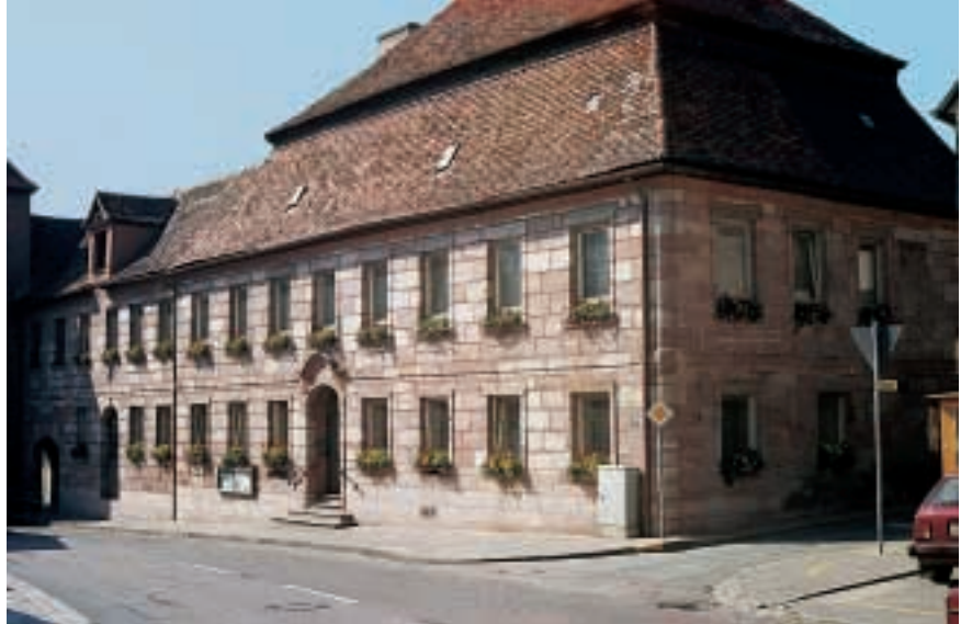
Abb. 7: Sandsteinhaus in Abenberg, Mittelfranken. – Beispiel für früher übliche Natursteinbauweise; der Schwerpunkt heutiger Sandsteinverwendung liegt in der Herstellung gesägter Platten zur Fassadenverkleidung
