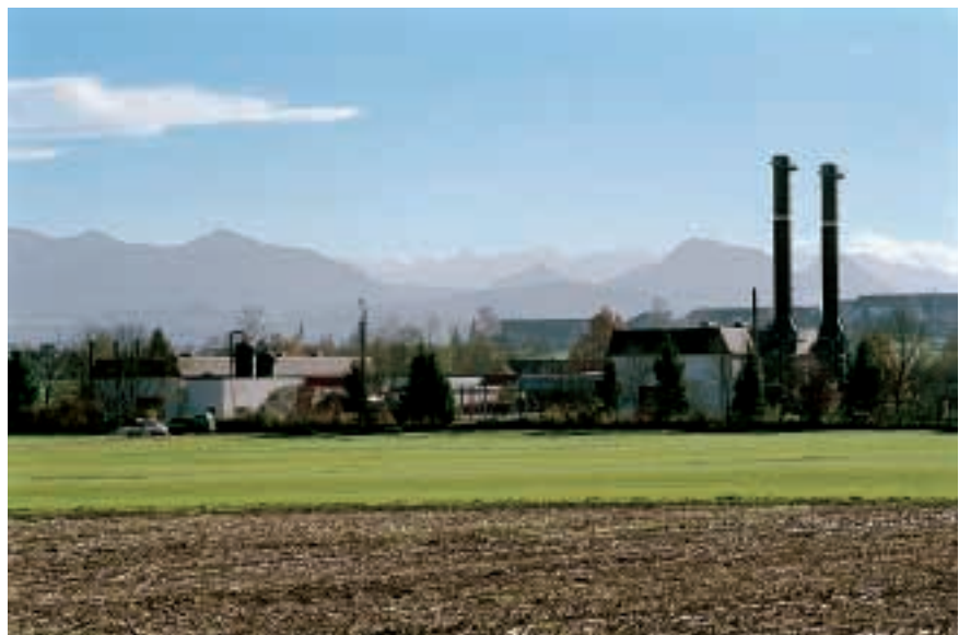
Abb. 27: Gasspeicher Inzenham-West bei Rosenheim
