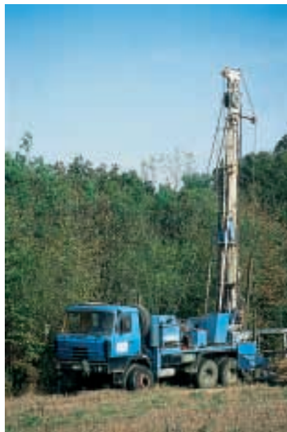
Abb. 23: Kernbohrgerät zur Erkundung von Rohstoffen
