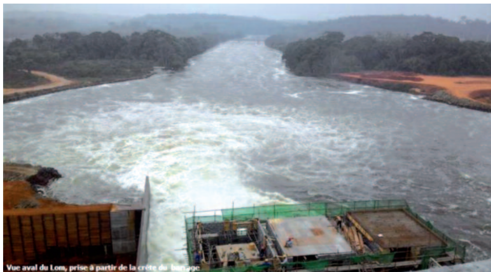
Vue aval du Lom, prise à partir de la crête du barrage
