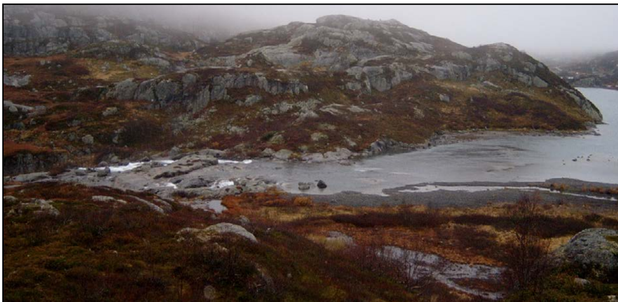
Figur 6.1 Utløp av Vesle Kjelavatnet og opprinnelig planlagt plassering av dam og inntak for overføringstunnelen til Førsvatnet.
