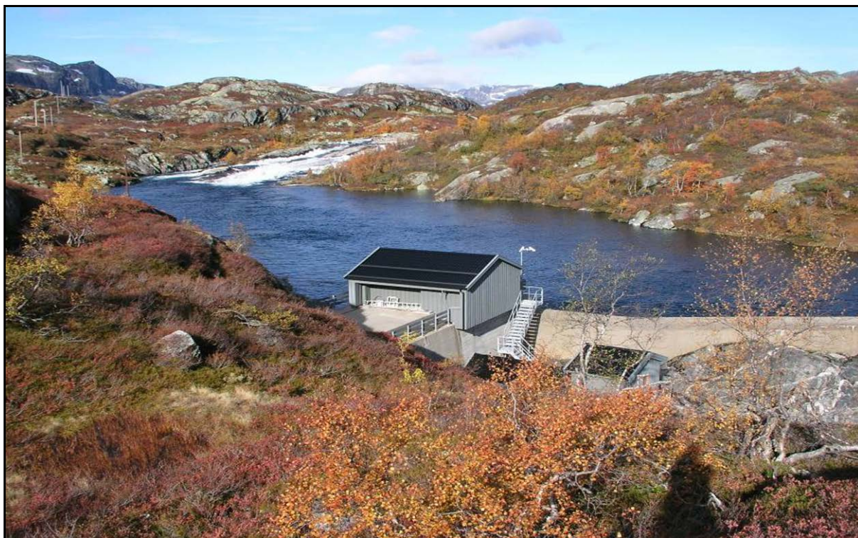
Figur 3.1 Inntaket i Kjelåi nedstrøms Vesle Kjelavatnet. Inntaksdam for overførings-tunnel til Førsvatnet. Stryket som får redusert vannføring sees i bakgrunnen.
