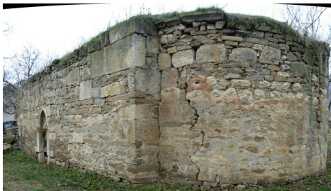
3. Церковь Сурб Саргис. Вид с юго-востока
