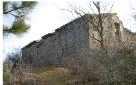
22. Церковь Сурб Урбат. Вид с северо-запада
