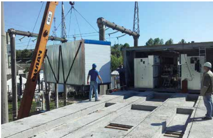
| Монтаж подстанции ЗРУ-10кВ из 42 камер КРУ серии КВ-02-М2. Крым, г. Симферополь. Май 2017 года
