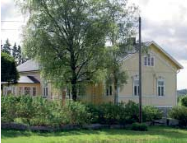
Hävältilän Pietilän päärakennuksessa on tyypillisiä uusrenessanssi-aihteita. Ikkunoiden T-karmimallit ovat myös peräisin 1800-luvun lopulta. – Maarit Riitijoki
