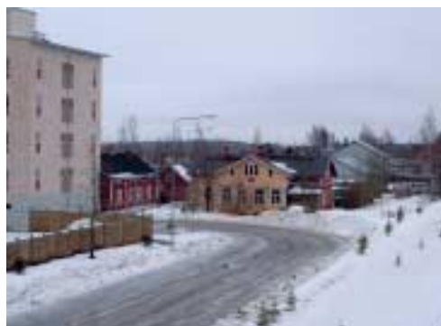
Käsityöläiskujan rakennuksia kerrostalokatveessa. – Eija Teivas
