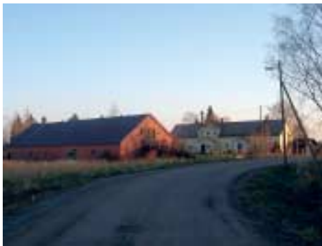
Lahdenkyläntie kulkee nykyisin Raukon tilan länsipuolelta. – Eija Teivas
