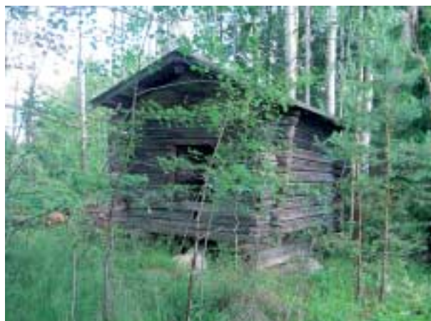
Tipan aitan lattialankkujen päät pistävät esiin seinien alta 1700-luvun tyyliin (pistolattia). Seinät levenevät ylöspäin, eli ne ovat liuhalla. – Eija Teivas.
