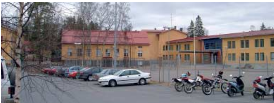
Sääksjärven koulussa on kolme selvästi erottuvaa kerrostumaa: 1930-luvun entinen asuntola-keittola, 1950-luvun koulu ja 2000-luvun alussa valmistunut laajennusosa.
