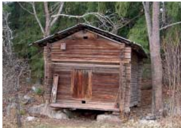
Vaakasuorista hirsistä tehtyä rakennetta kutsutaan lamasalvokseksi, joka tunnettiin jo kivikaudella. Nurkkasalvokset lukitsevat kehikon tukevaksi ja aina kahden hirren yhdistävät puuvaarnat estävät puuta kieroutumasta sivusuunnassa. – Maarit Riitijoki
