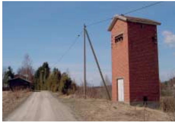
Muuntajat sijoitettiin aluksi tiilirakenteisiin muuntamoihin. Nurmen entisen koulun lähellä on yksi jäljellä olevista muuntajista, jotka yleensä ovat maamerkkejä maisemassa. – Eija Teivas
