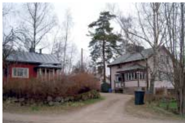
Kaikki ei ole miltä päältä näyttää. Rankorakenteita on päällystetty laudoituksella, rappauksella, tiilimuurauksella ja erilaisilla levyillä. Hirsirakenteita on verhottu yleensä vain laudoituksella ja joskus rapattukin. Kuvassa jälleenrakennuskauden talo Veräjänhaustassa. – Eija Teivas
