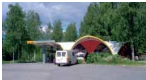
Muovista ja lasikuidusta Gulf-ketjulle suunniteltu huoltoasemamalli oli 1960-luvun ennakkoluulotonta designia. – Eija Teivas
