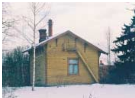
Ratavartijoiden tyyppipiirustusten mu- kaan tehdyt tuvat olivat niin pieniä, että ullakkoportaat tehtiin ulkopuolelle. – Eija Teivas.
