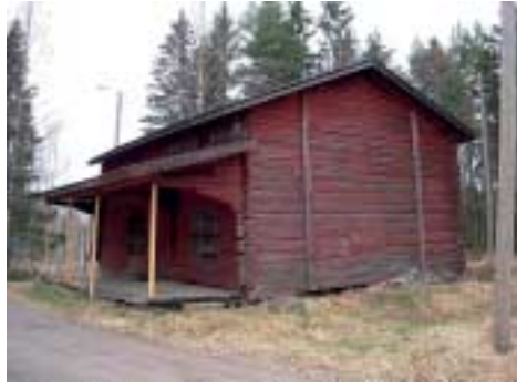
Rantalan riihi on maalattu. Useimmiten riiket, samoin kuin laudoittamattomat aitatkin, ovat käsittelemättömiä. – Eija Teivas
