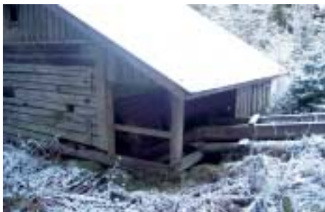
Myllymäen puomyllyä pyörittää vesiratas. Ruuheen ohjataan vettä vain silloin, kun mylly käy. – Eija Teivas.
