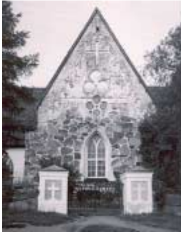
Lempäälän harmaakivikirkossa on tiilestä tehty päätykoristelu ja ikkunoissa goottilaiset suippokaariholvit. Satakuntalaismallisessa tapulissa alin kerros on nelikulmainen ja kaksi ylintä kahdeksankulmaisia. Katon muodossa näkyy barokin vaikutus. – Postikortti Jorma Peltomaan ja Esko T. Koirasen kokoelmista.
