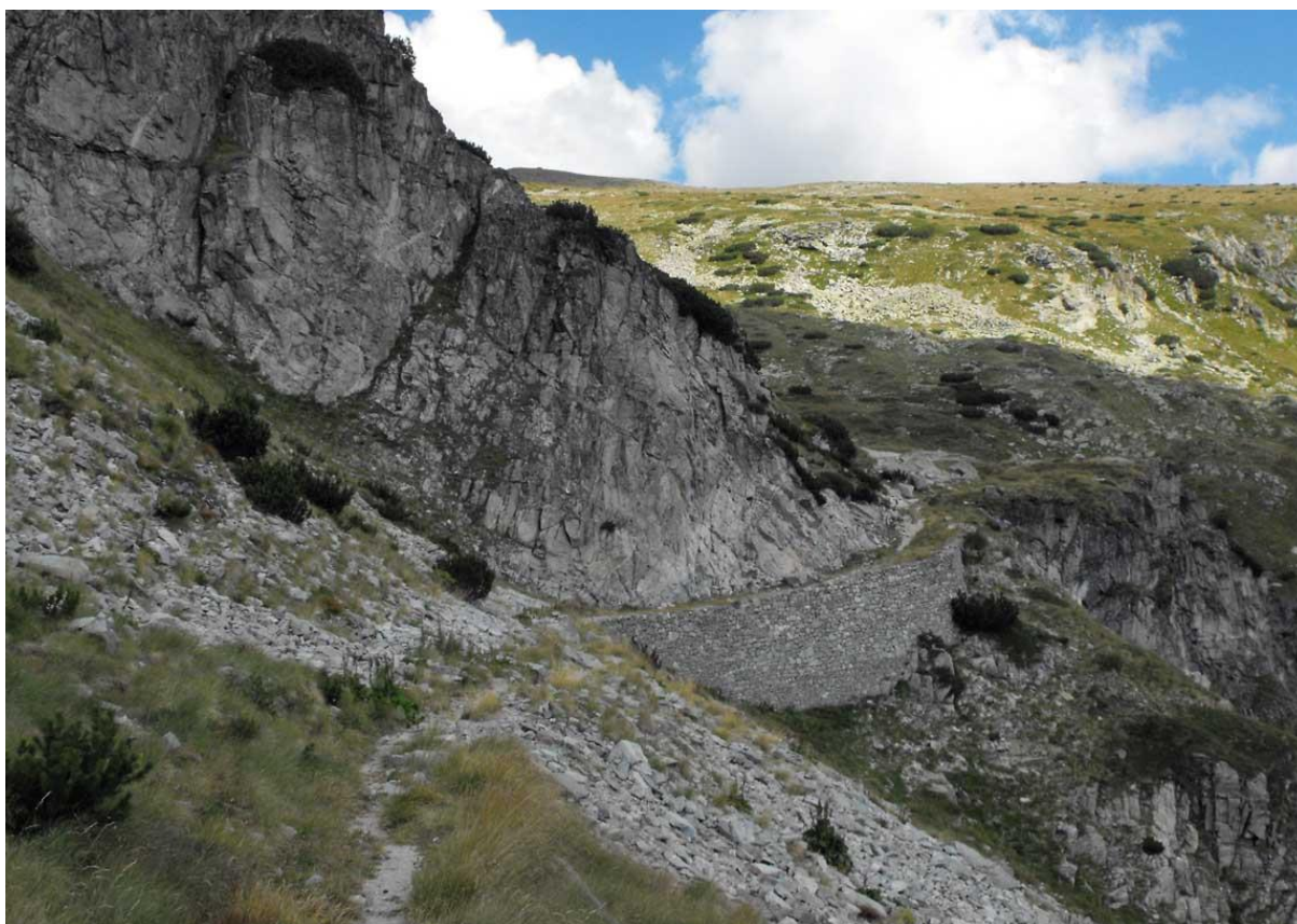
Фиг.1.9.-22. Участък от кайзеровия път, намиращ се на източния склон на в. Песоклива вапа. Съвременните склонови процеси са заличили трасето, превърщайки го в тясна пешеходна пътека.
