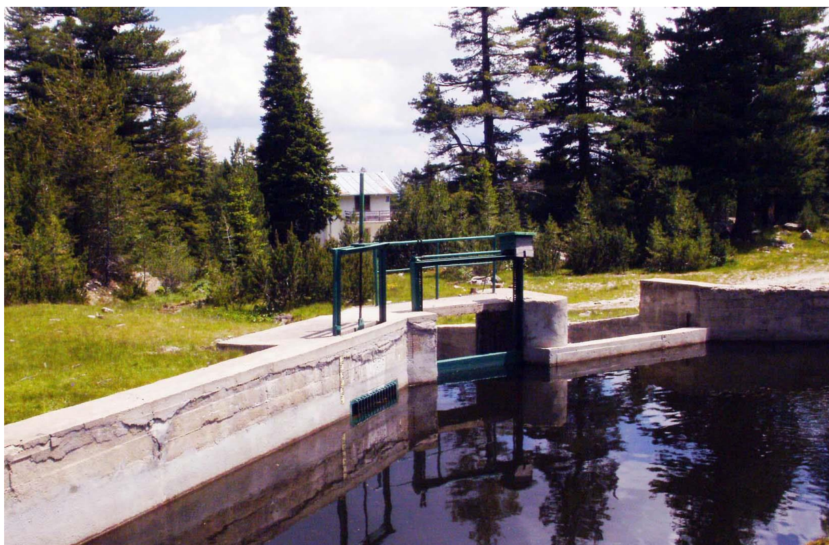
Фиг.1.19.-12. Водохващане от деривацията на кота 1900
